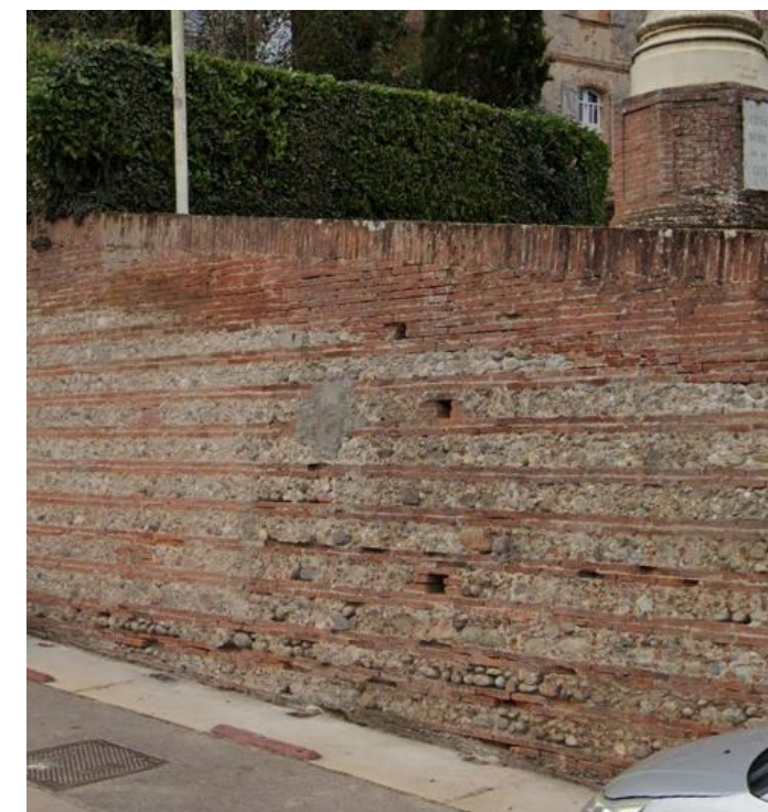
Restauration des murs et façades historiques
