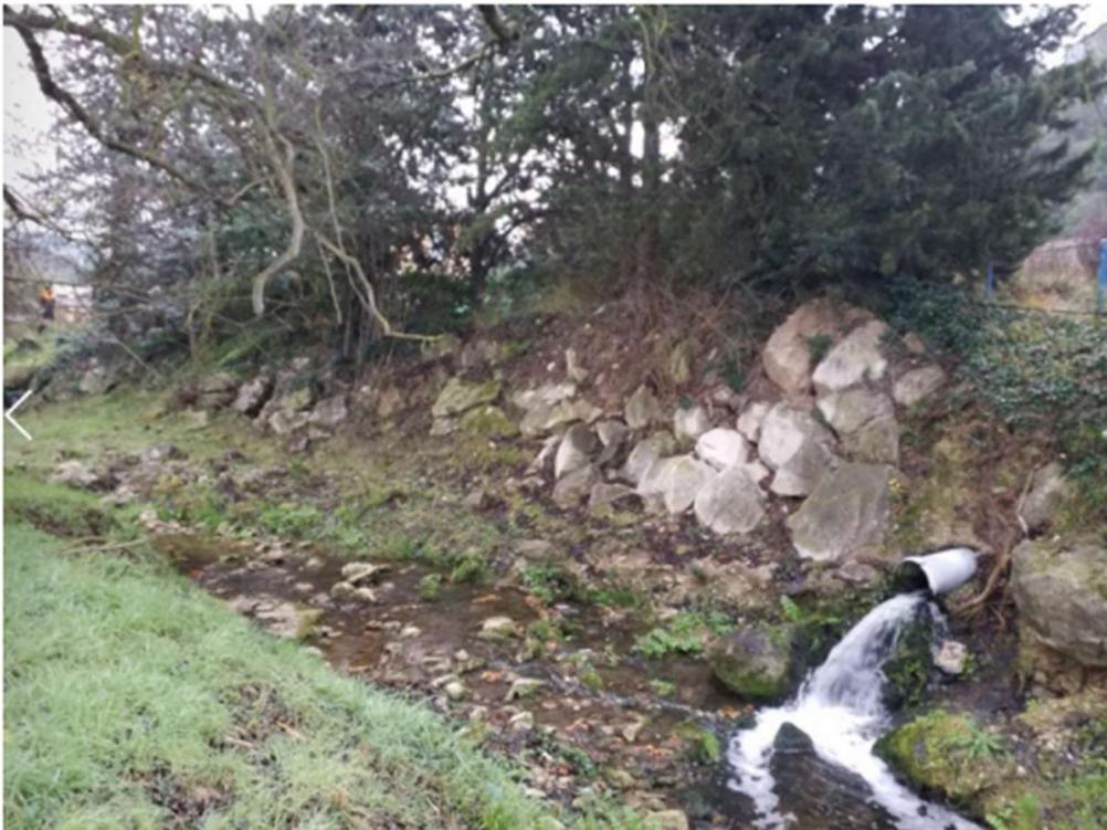
Figure 153 : Photographie de la digue de protection de la station d'épuration du Castellet et du rejet des eaux traitées dans le Grand Vallat (source : Diagnostic Grand Vallat, 2020)
