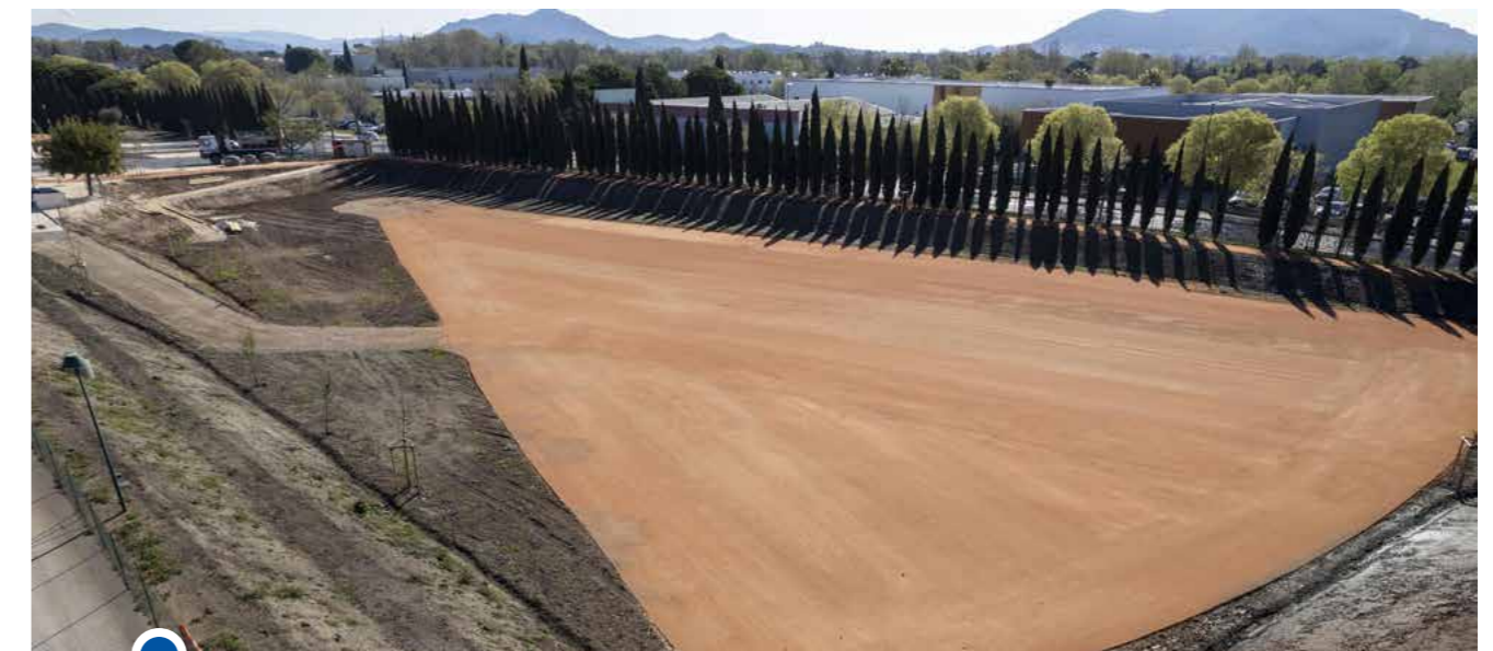
Illustration des travaux en cours sur la Planquette (source : MTPM, 2023)
