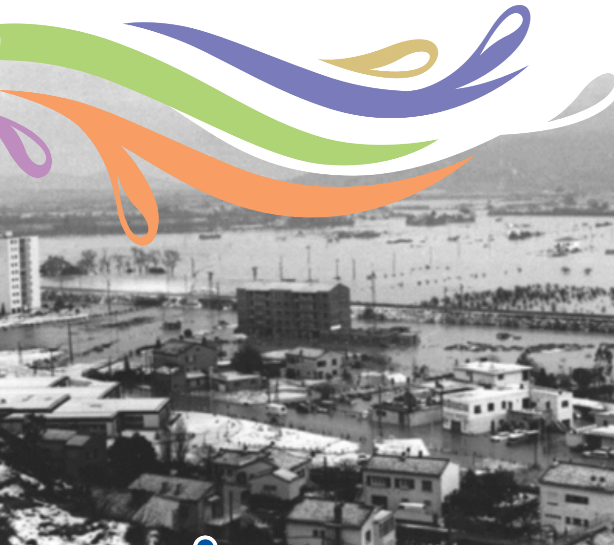
Inondation de l'Eygoutier et de la plaine de la Garde en janvier 1978 (source : MTPM, 2017)
