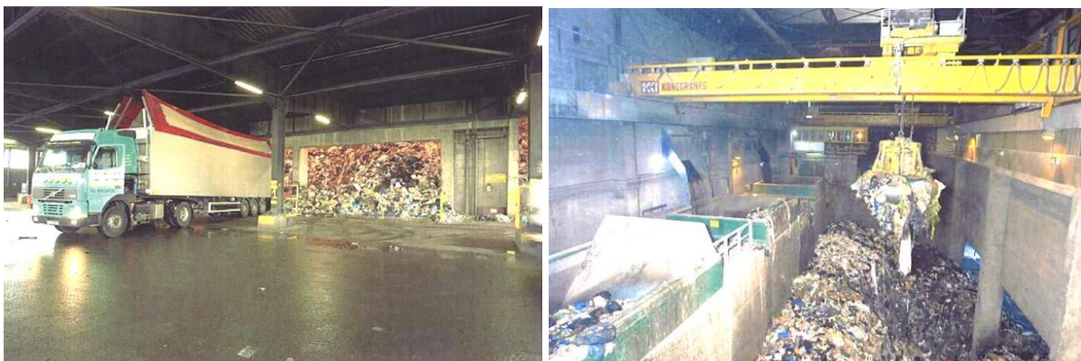
Figure 6 : Vidage des OM dans la fosse et alimentation des fours par le grappin (Source : site internet SETMI)
