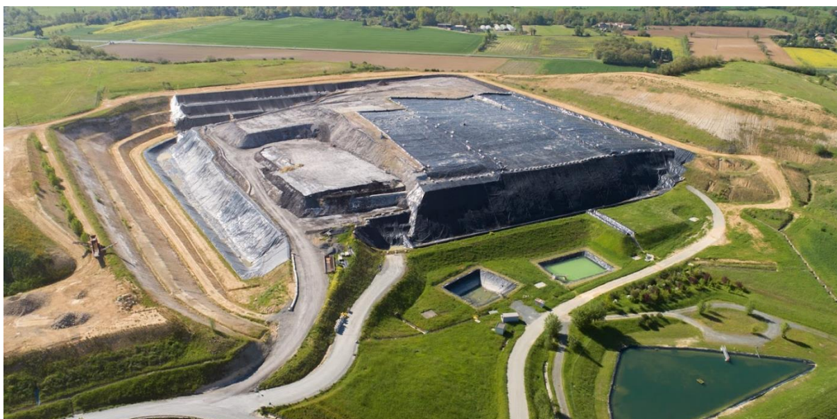
Figure 13 : Installation de Stockage de Déchets Dangereux Occitanis à Graulhet.
