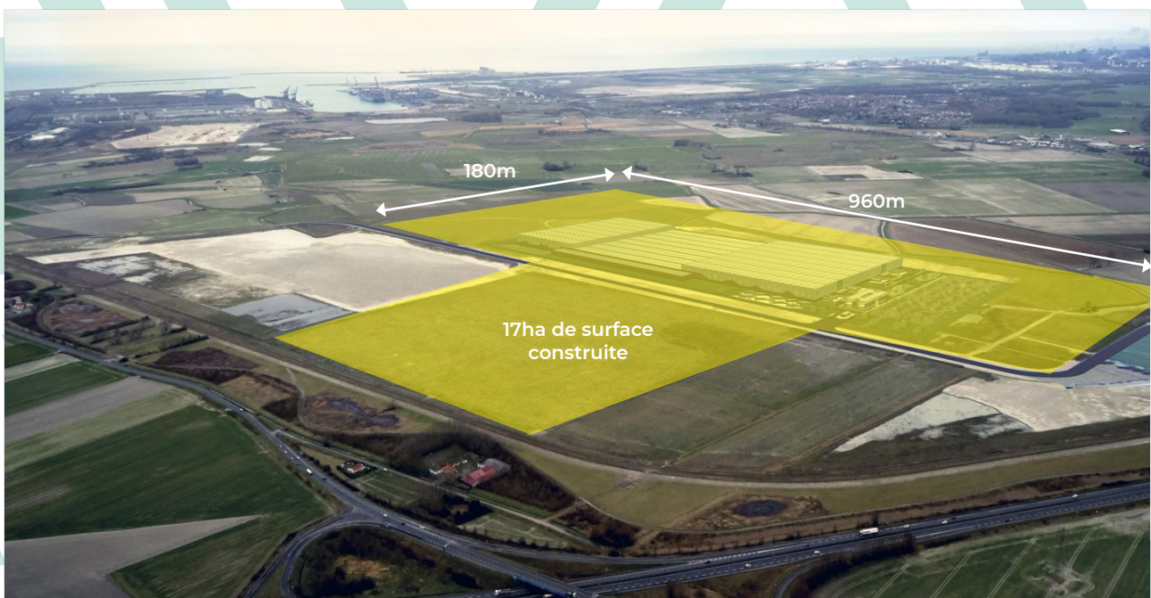
Reconstitution aérienne de l'implantation de la future usine de Verkor sur la Zone Grandes Industries
