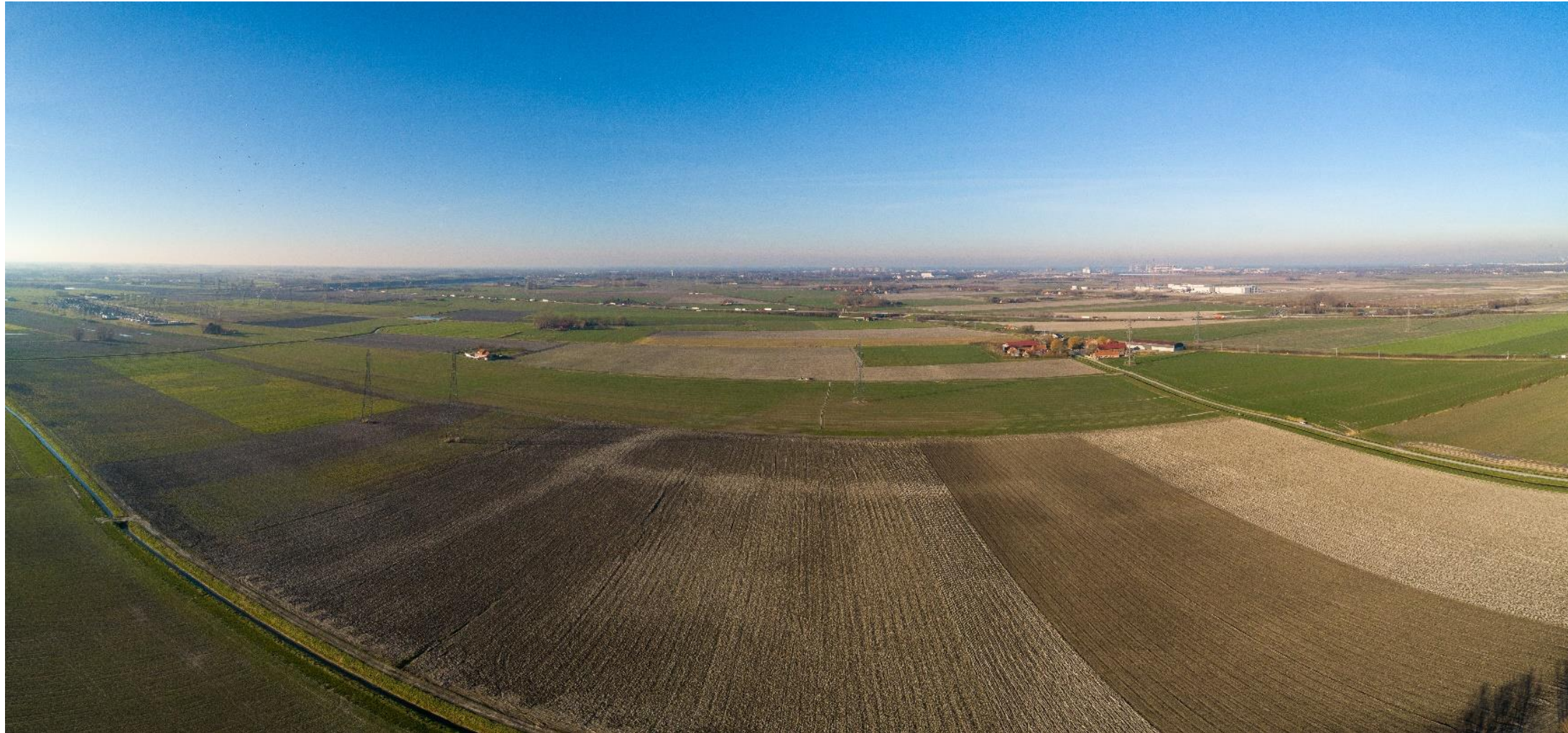
Vue aérienne de la zone du futur poste de Flandre Maritime
