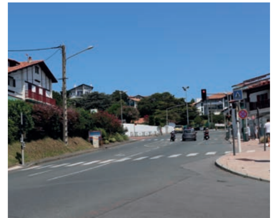
✦ RD 810 - au niveau du carrefour à feu
