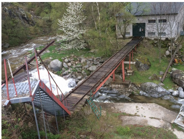
Installation hydroélectrique à Sahorre sur la Rotja
