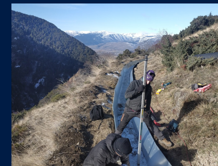
Travaux d'économies d'eau sur le canal d'Espluga de Llo ©CC Pyrénées-Cerdagne
