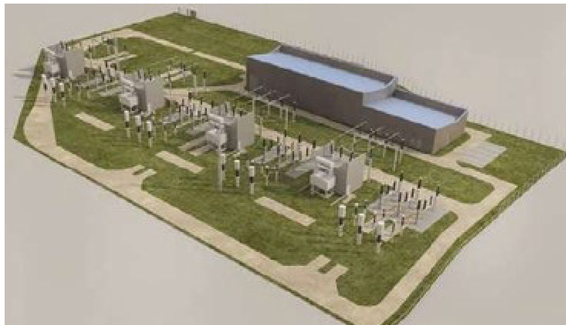
Figure 9. Schéma de principe d'un équipement de compensation d'énergie réactive (surface : entre 4 et 6 Ha) - (source : RTE)
