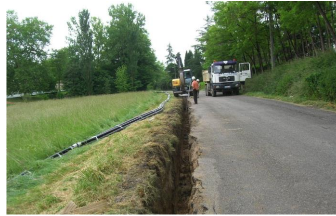
En fourreaux PEHD (réseaux peu denses)
