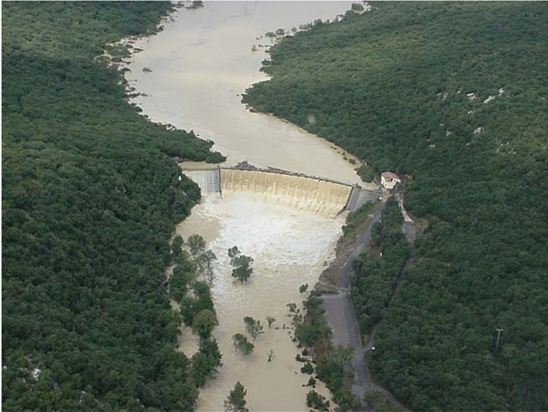
Photo 2 : Le barrage de la Rouvière lors de la crue de septembre 2002
