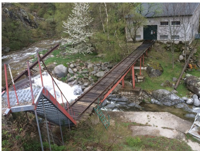
Installation hydroélectrique à Sahorre sur la Rotja
